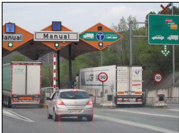
Exemplu de stație VIA-T
